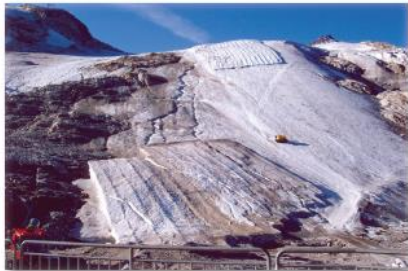
Am Gletscher wird im Frühjahr 2006 Teile der Piste mit Planen abgedeckt.
