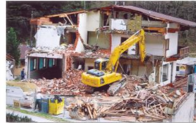
Die alte Tankstelle wird am 21. April 2009 abgerissen
